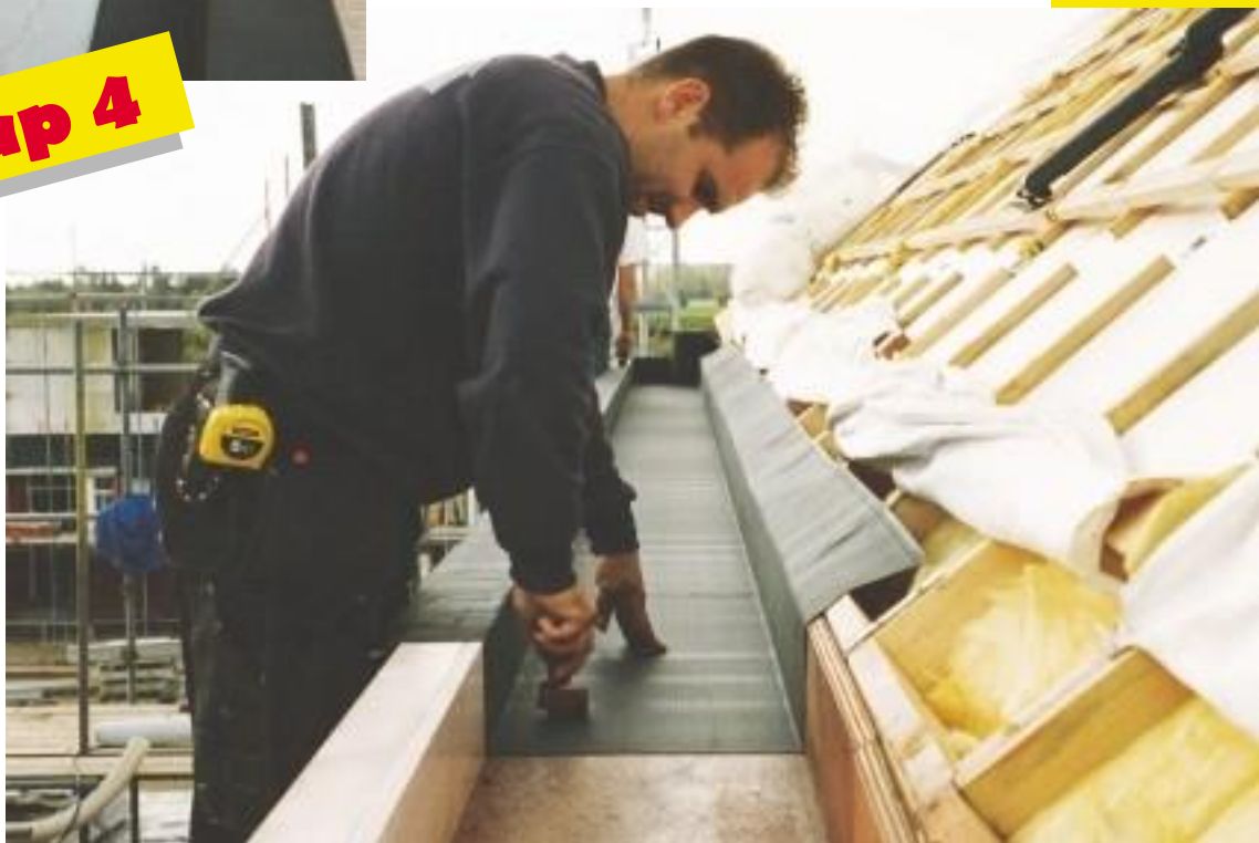
Het kleven van EPDM rubber
